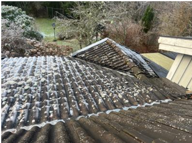
Vy gällande delar av yttertaket.
