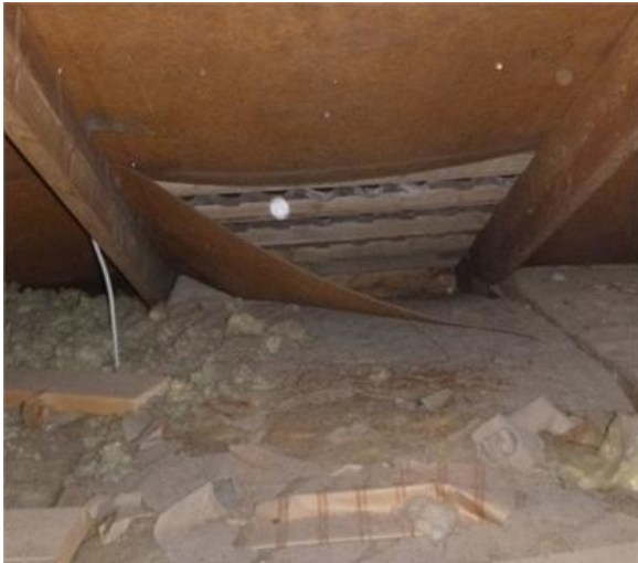
Nedhängd träfiberskiva till underlagstaket
