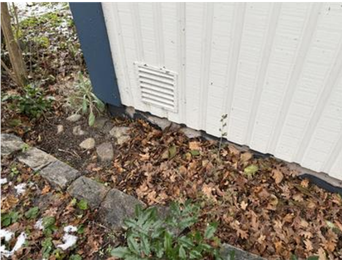
Grund/sockel med färg och putssläpp.
