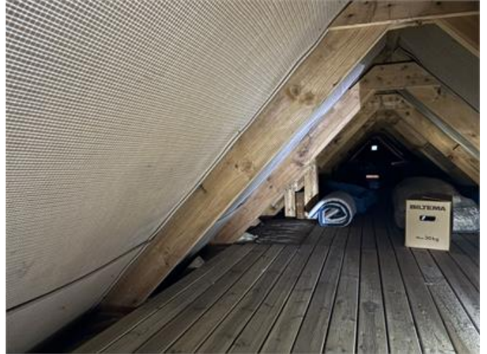
Ingen förhöjd fukt uppmättes i takkonstruktion/vindsutrymme vid besiktningen.
