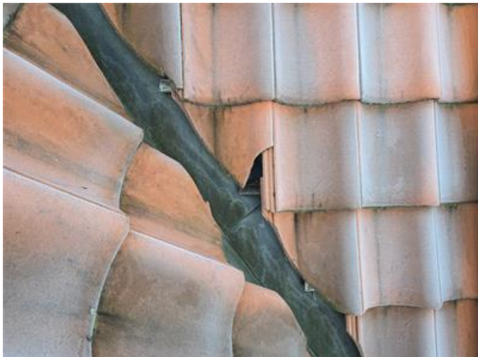
Exempel från yttertak/rännfal.
