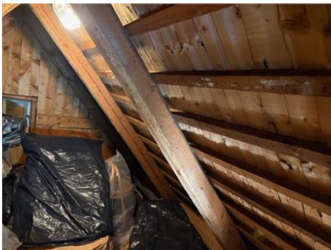
Allmän bild från vindsutrymmet
