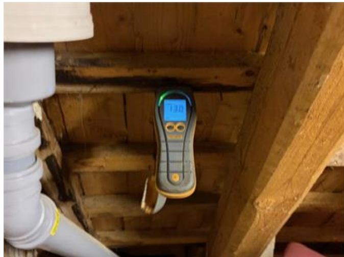
Äldre missfärgning förekommer vid murstock som uppkom innan skorstenen plåtades in. Ingen förhöjd fukt indikerades vid besiktningen
