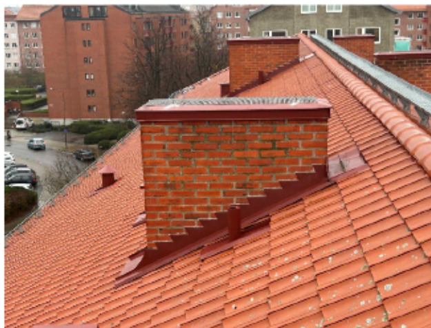
Omfogad skorsten med fågelnet från 2013
