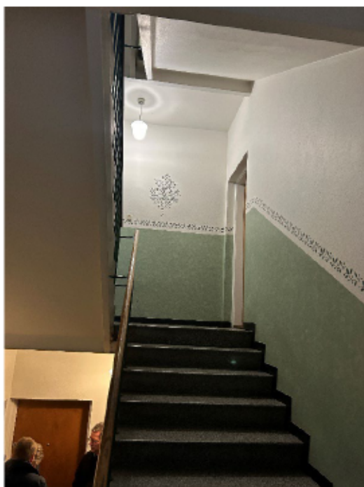
Trapphus med trähandledare
