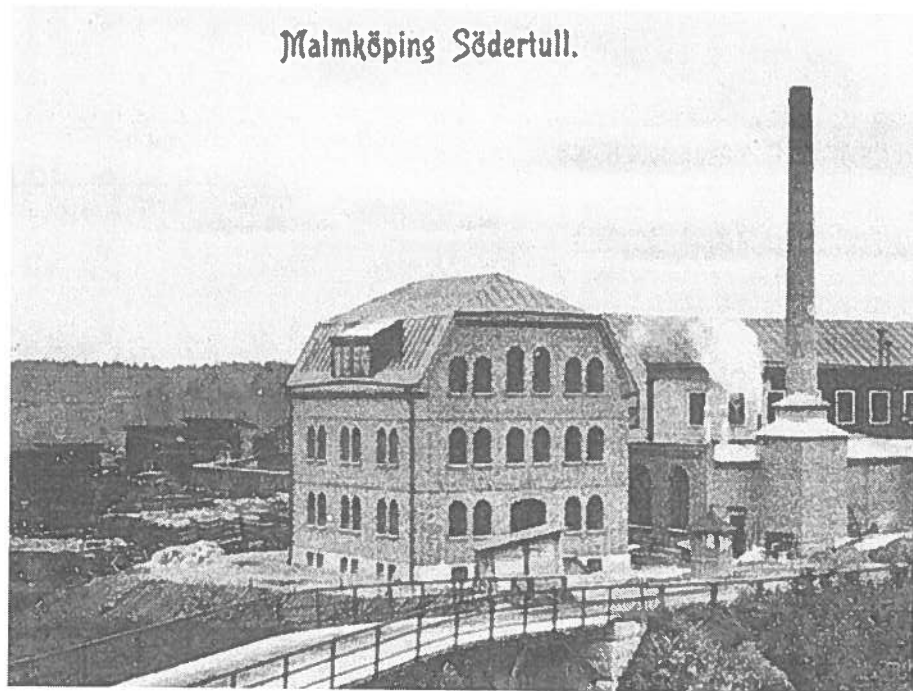
Bild 1. Gamla kvarnen "Södertull". Okänd fotograf. Bilden visar byggnadens ursprungliga utseende och takform, som fastighetsägaren avser återställa. Bilden är hämtad från Malmö stads hembygdsförening.
