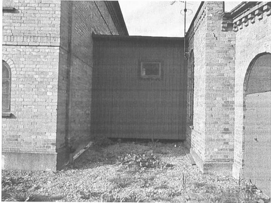
Bild 5. Tillbyggnaden som avses rivas. SLM D2021-0540.
