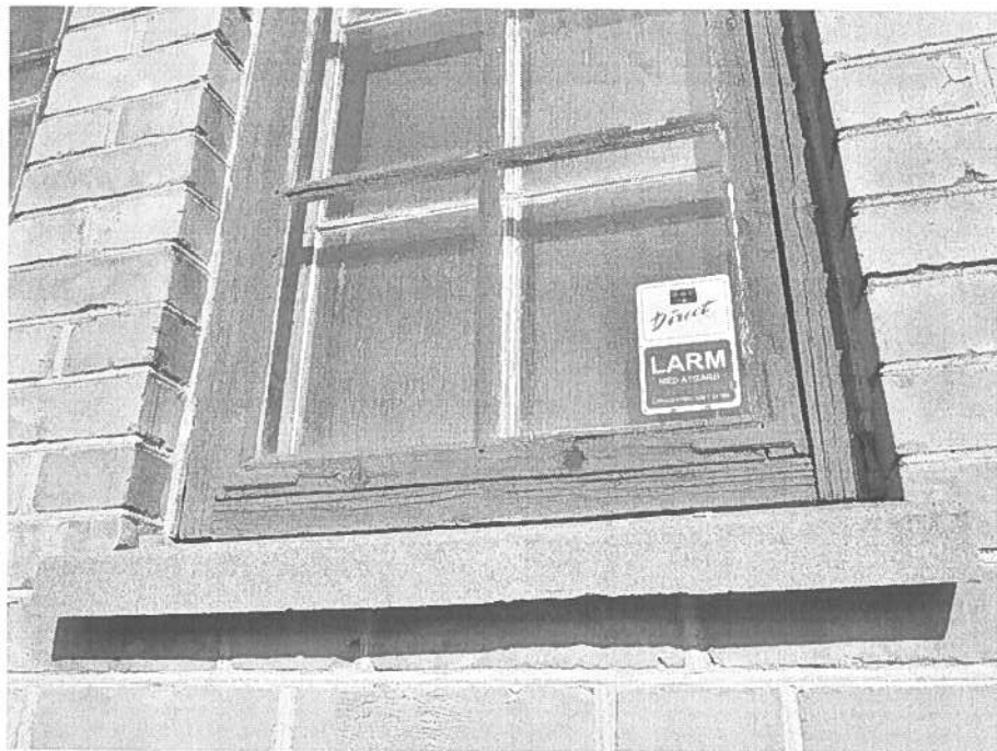
Bild 6. Ursprungliga fönster på södra fasaden. SLM D2021-0541.
