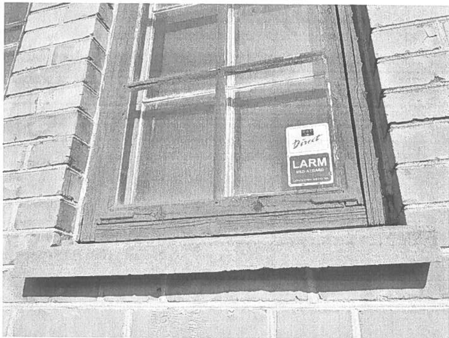
Bild 6. Ursprungliga fönster på södra fasaden. SLM D2021-0541.
