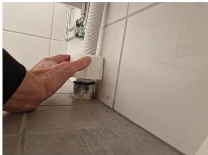
Väggnära rörgenomföring i våtrum.
