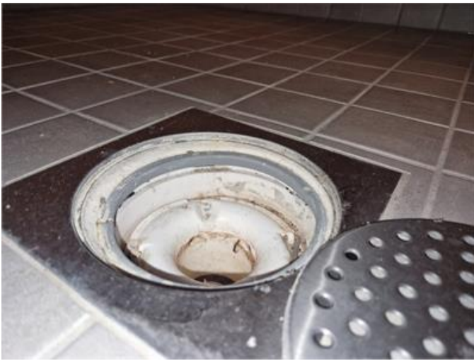
Golvbrunn i bastu.
