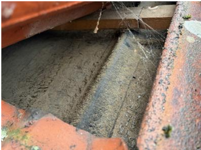
Stickprovskontroll av läkt och tjärpapp från baksidan
