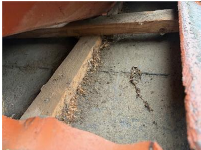
Stickprovskontroll av läkt och tjärpapp från framsidan
