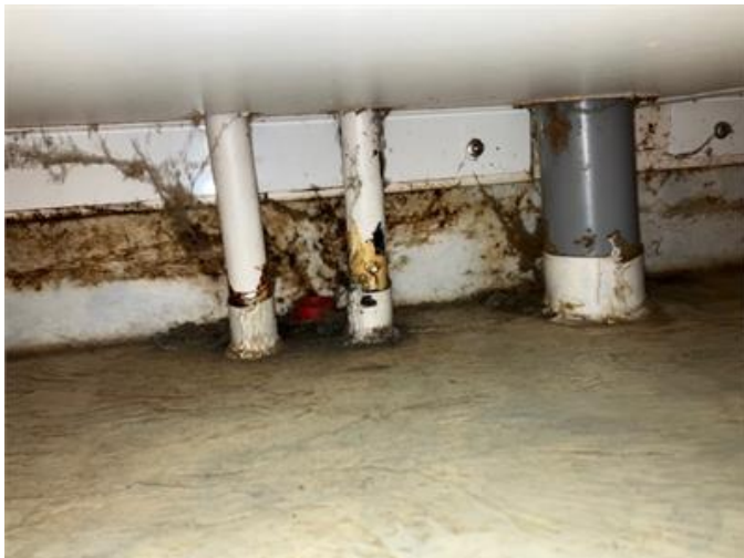
Rör genomföring i golvet i duschrummet
