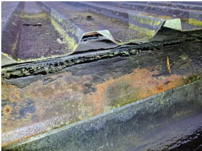
Tak (Låglutande): Otätheter mellan takpapp och fotplåt
