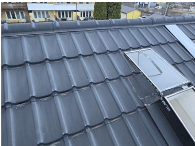
Överblick del av yttertak.
