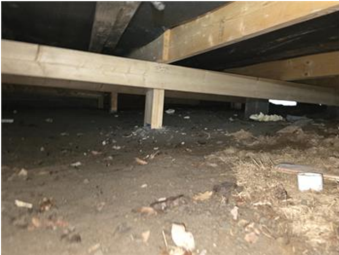
Plintgrund: Översiktsbild mot väst, obehandlat virke noteras.
