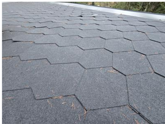
Tak: Underlagstak har rest sig lokalt, här mot norr.
