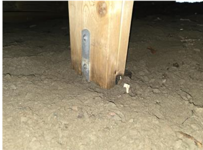
Plintgrund: Exempelbild på obehandlade stolpar ner mot mark.
