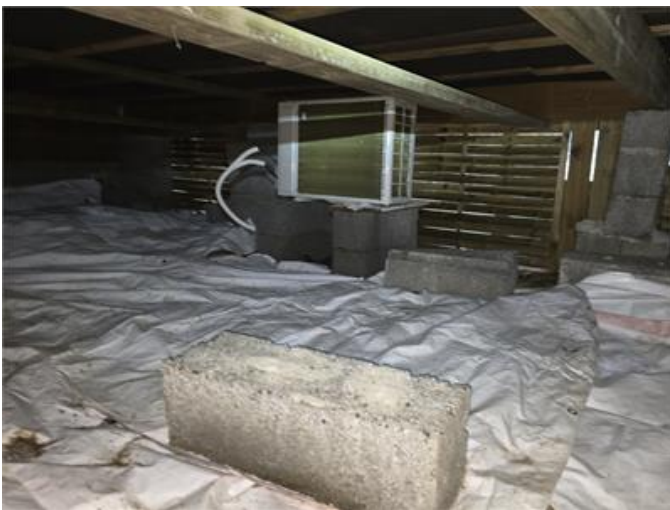
Plintgrund: Översiktsbild mot öst, rötskyddsbehandlat virke noteras i konstruktionen. Värmepumpens utedel är placerad i utrymmet.
