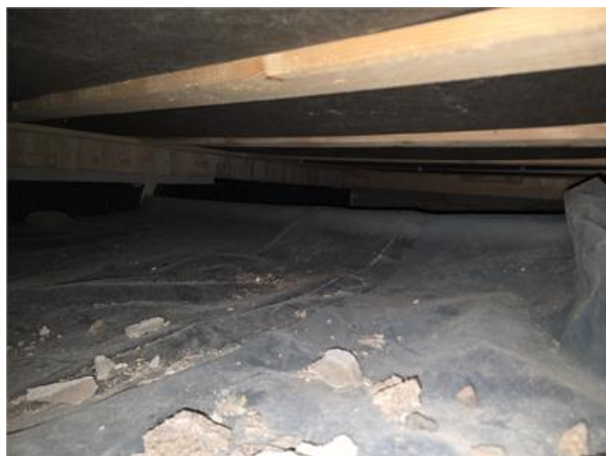
Bilden visar del av krypgrunden som är låg, under sidoentrén. enbart sett från öppningar i grundmuren. Ej fysiskt åtkomligt.
