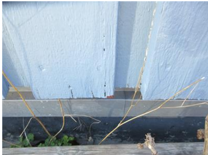
Rötskadad fasadpanel
