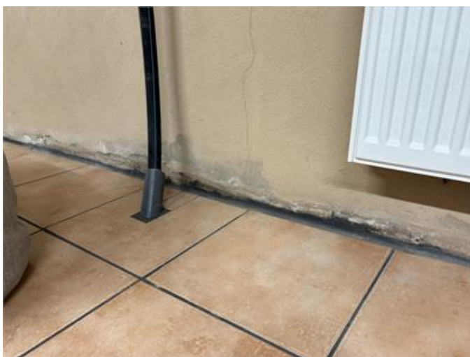
Viss fuktinträngning i normal omfattning noterades i källaren.
