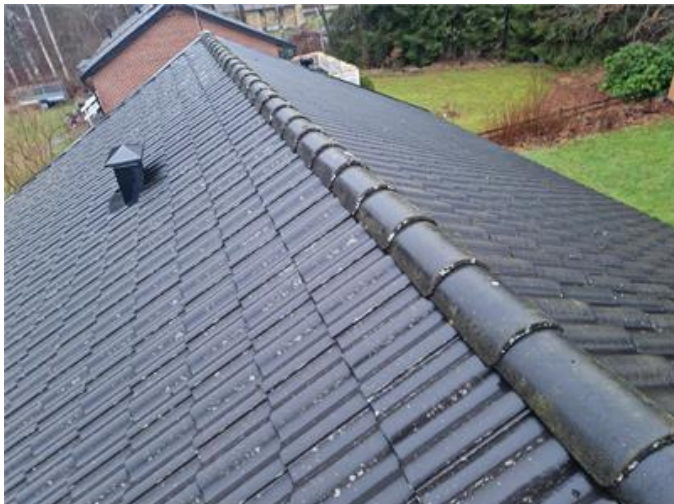
Vy på yttertak
