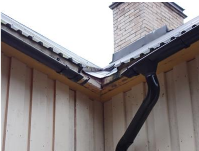
Innerhörn på hängränna saknas vilket medför ökad fuktpåverkan på fasad.
