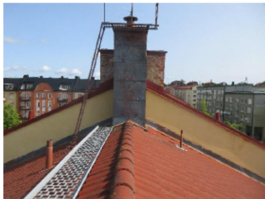
Taket renoverat ca 1985 men plåt är gammal
