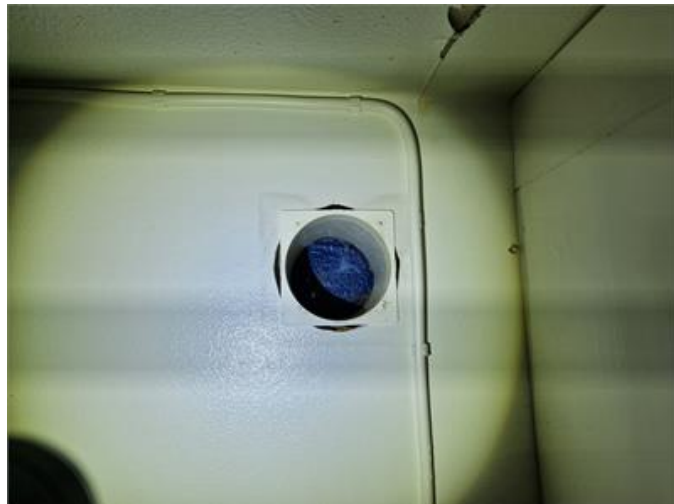
Allmänt/Ventilation: Ventilationsinstallationer avslutas mot betongvägg
