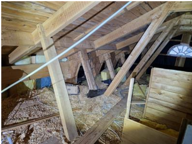
Vind: Ombyggda takstolar och avvaxling med limträbalk förekommer.
