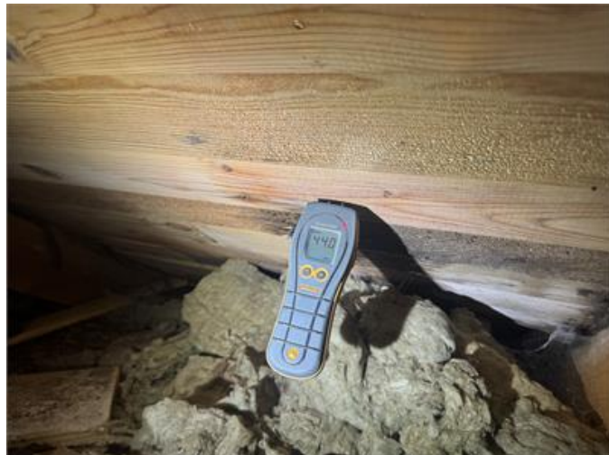
Förhöjda fuktkvotsvärden vid kontroll avnockvind.
