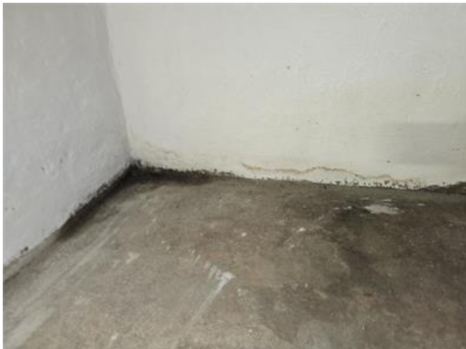
Grovkällare: Exempelbild på fuktanvisningar.
