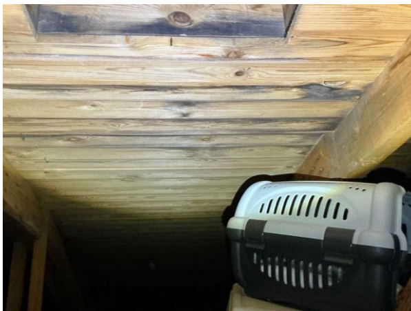
Bild 2: - Utvändigt, Vind, Huset är självdragsventilerat se riskanalysen Det noterades spår av äldre läckage på underlagstak...
