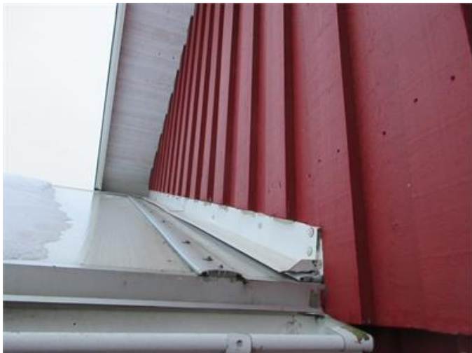
Vinkelplåt monterad utanpå fasadpanel
