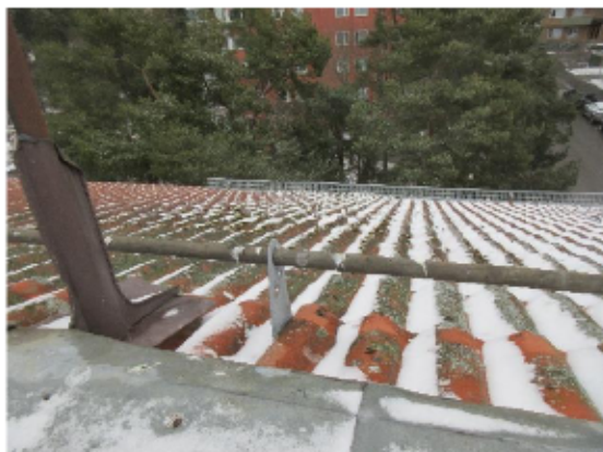
Yttertak från ca 1996
