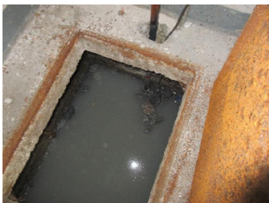
Pumpgrop gör avlopp i källarplan
