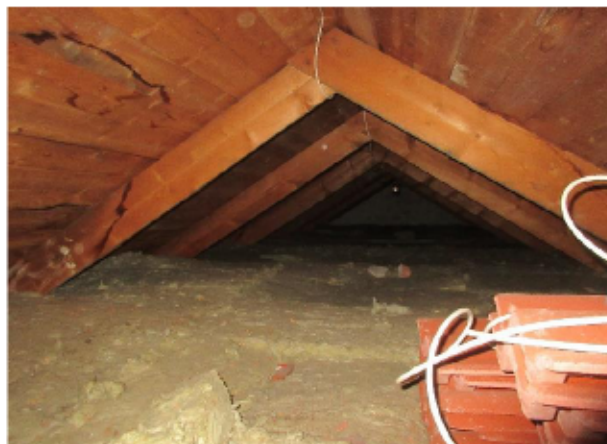
Toppvind, med tilläggsisolering
