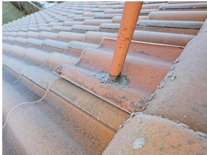
Bilden visar "Svanhals" som inte nyttjas med fjärrvärme.
