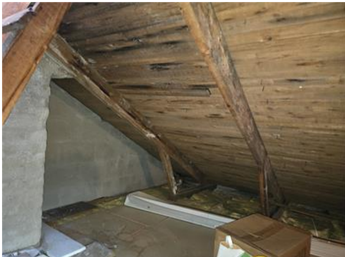
Överblick del av vinden.
