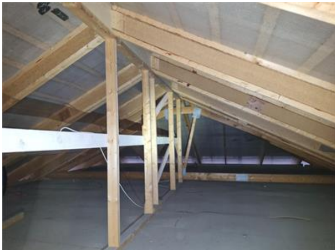
Nockvind, underlagstak av armerad plastfolie.
