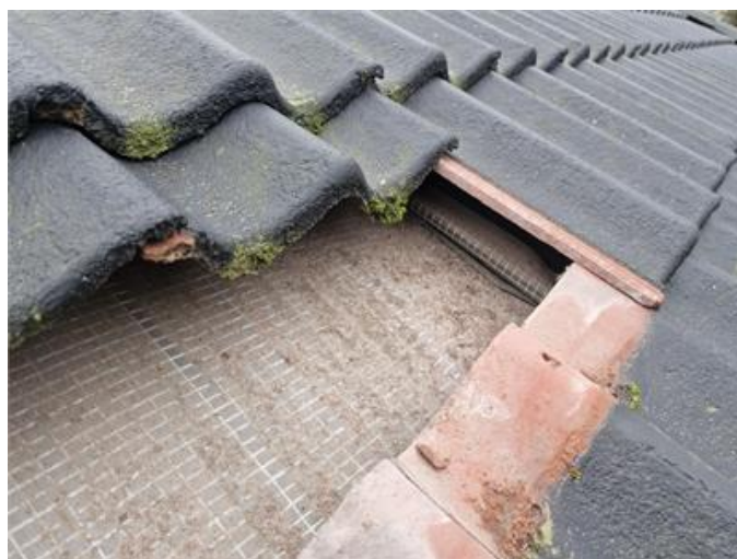
Tak, målade takpannor ovan underlagstak av armerad plastfolie.
