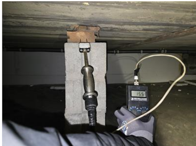
Fuktmätning i krypgrund.
