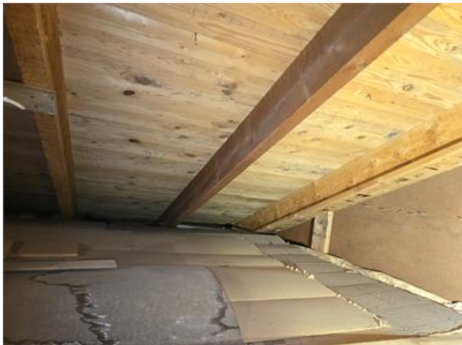
Exempel från vindsutrymmet ovan tillbyggnaden.
