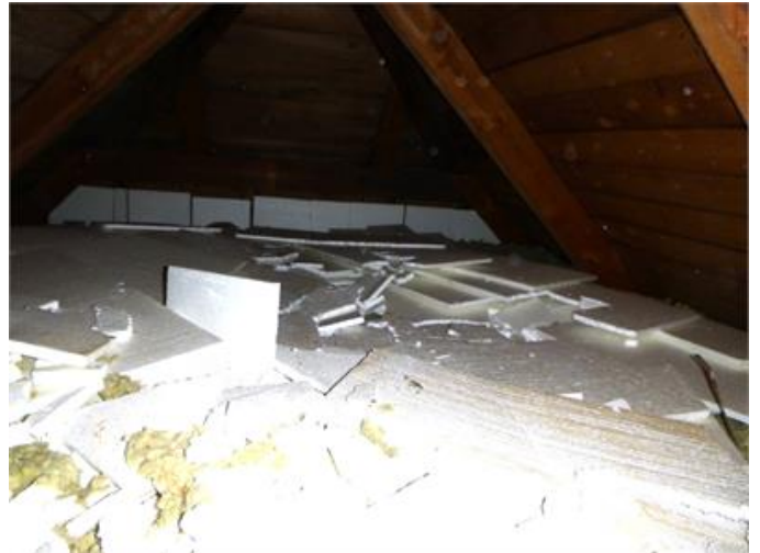
Vindutrymme isolerat med cellplast
