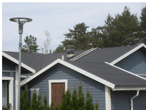
Nymålade fasader och ny takbeläggning
