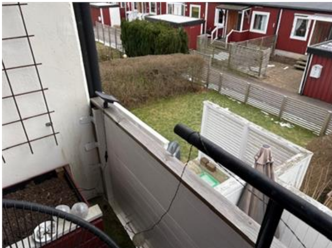
Bilden visar balkongräcket som bitvis är för lågt.
