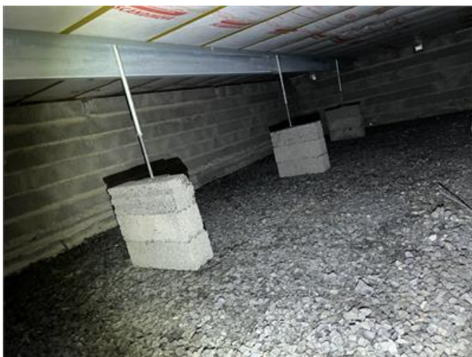
Krypgrund: Översiktsbild sektion 3.
