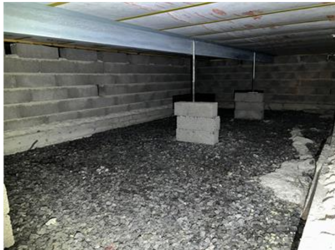
Krypgrund: Översiktsbild sektion 2.
