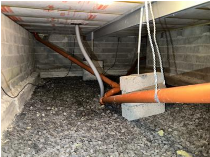
Krypgrund: Översiktsbild sektion 1.
