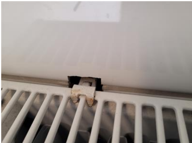
Radiator är infäst bakom kakel.
