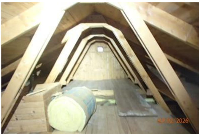
Generell bild på vinden.
