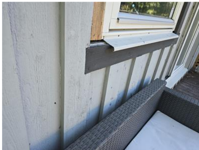
Exempel på otätheter i fasad.
