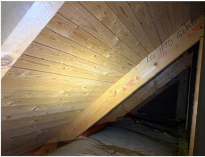
Allmän bild från vindsutrymmet
