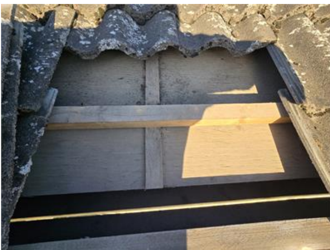
Tak: Stickprovkontroll under pannor.
