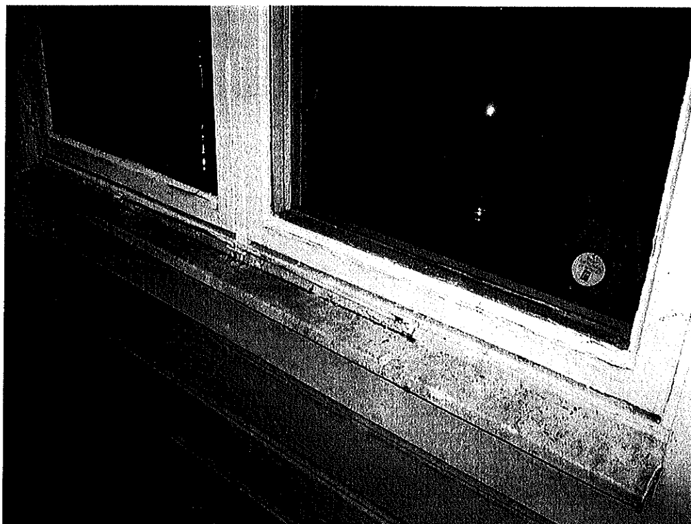
Fönsterbågar och karmar med kommande behov av renovering
