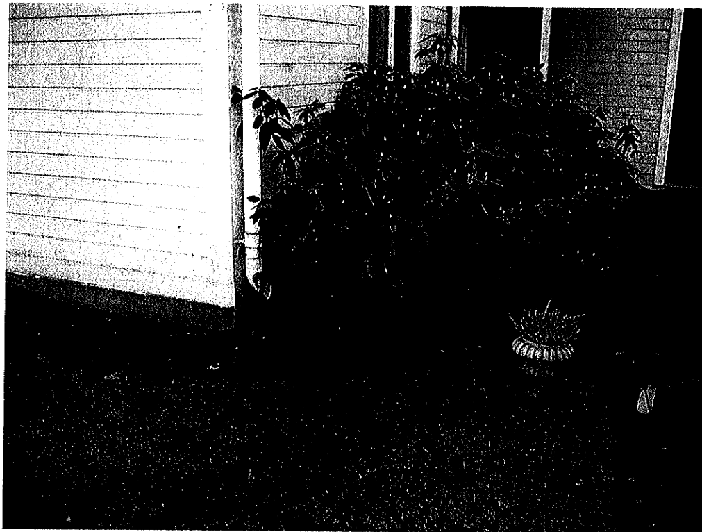
Vatten från stuprören avleds ej
