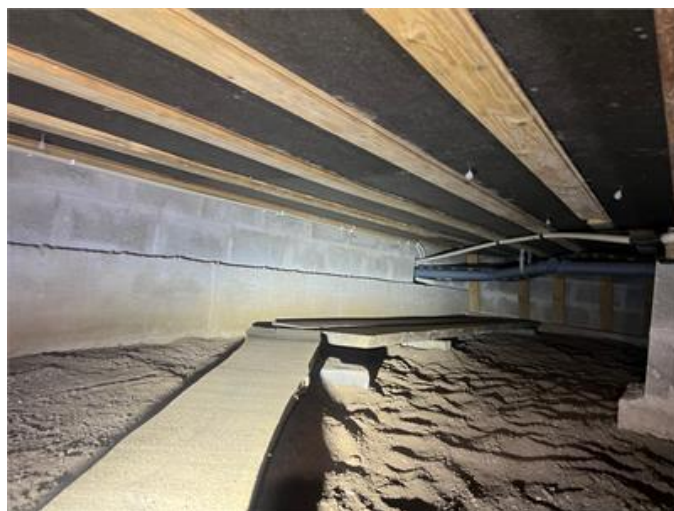
Bilden visar del av den senare kryppgrunden.
