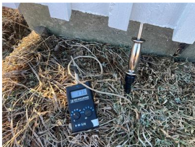
Fuktkvotsmätning, se bilaga kontroll av konstruktion.
