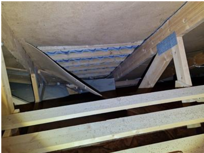
Vind: Masonitskivor har delvis böjt sig/delvis lossnat.
