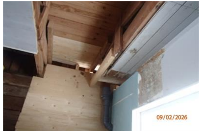
Tidigare skada från läckage har åtgärdats i garaget.
