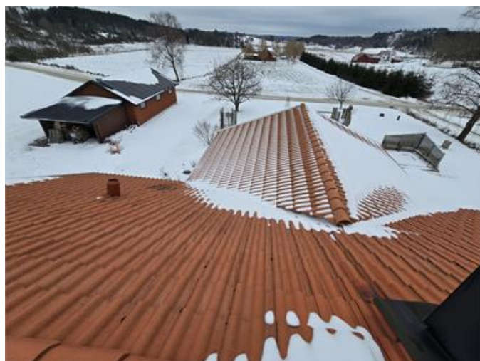
Tak: Översiktsbild mot söder.
