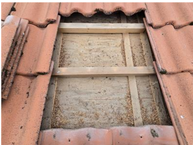
Tak: Stickprovskontroll under pannor (träfiberskivor utan yttre täckning av papp). Löv/frömjöl noteras.
