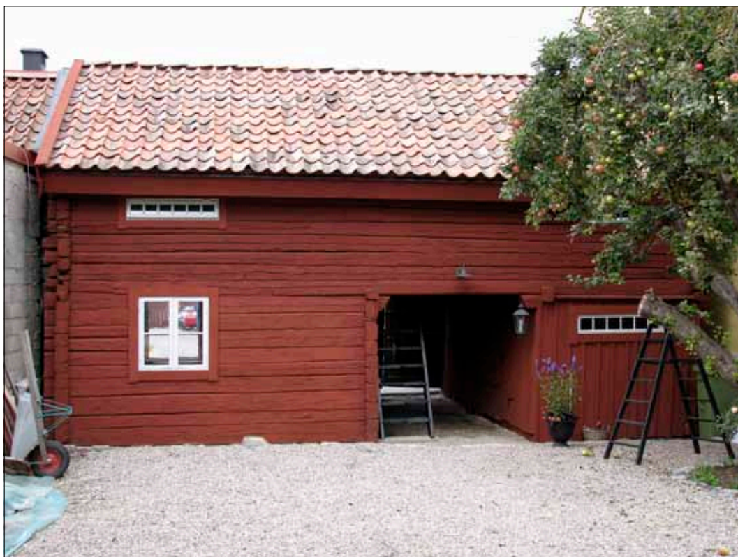
19 Gårdsfasaden från öster efter avslutad renovering, 20080915 (D08-667).
