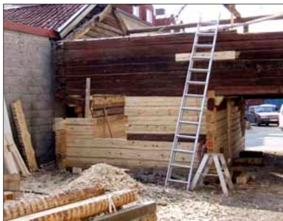
14 Byggnadens södra del från nordost, 20080404 (D08-657).
