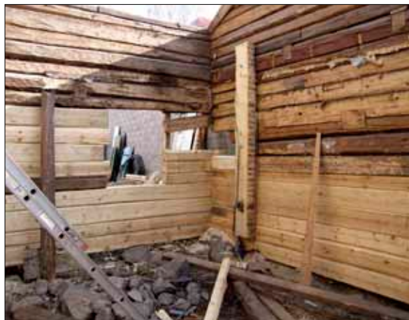
13 Den tidigare butikslokalen från nordost under pågående renovering, 20080404 (D08-656).
