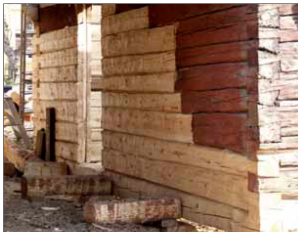
15 Portlidrets södra sida från nordväst, 20080404 (D08-658).
