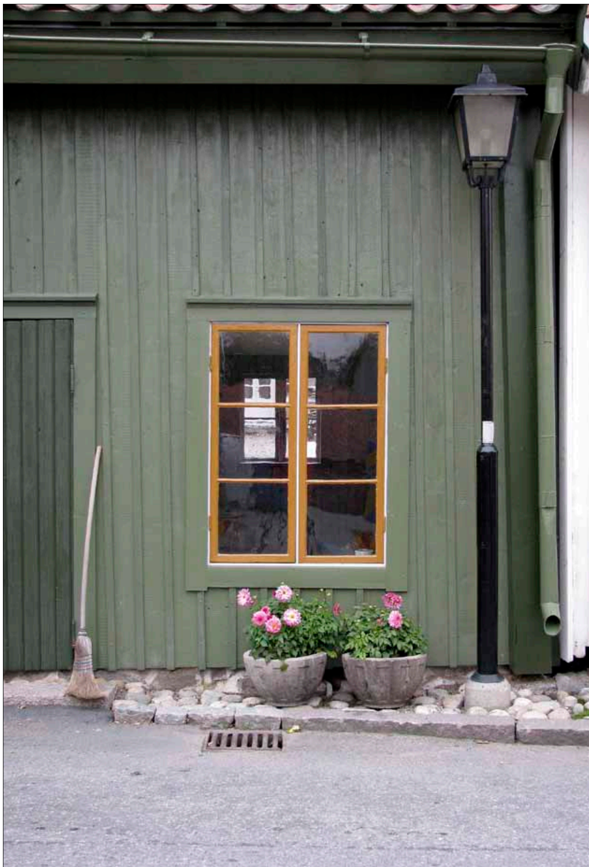
23 Gatufasadens södra del från väster efter avslutad renovering, 20080915 (D08-664).
