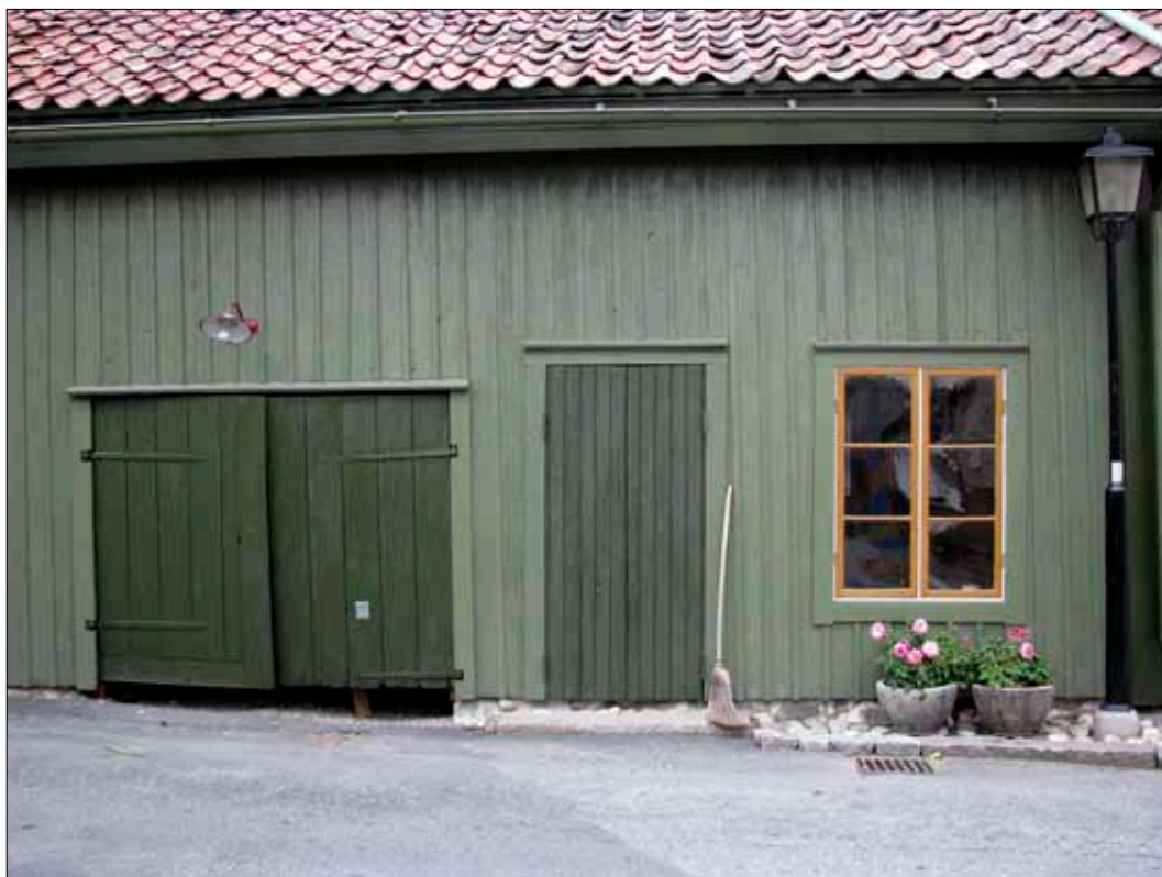
20 Gatufasadens södra del från väster efter avslutad renovering, 20080915 (D08-663).
