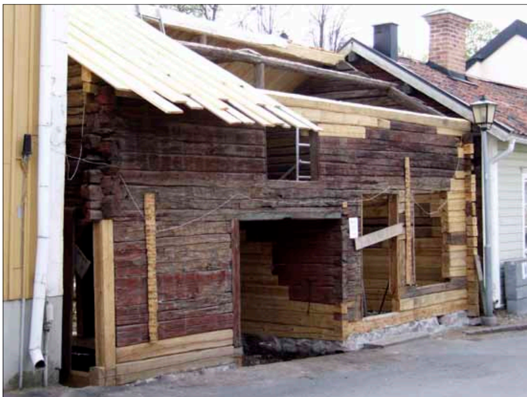
12 Gatufasaden från nordväst under pågående renovering, 20080507 (D08-659).
