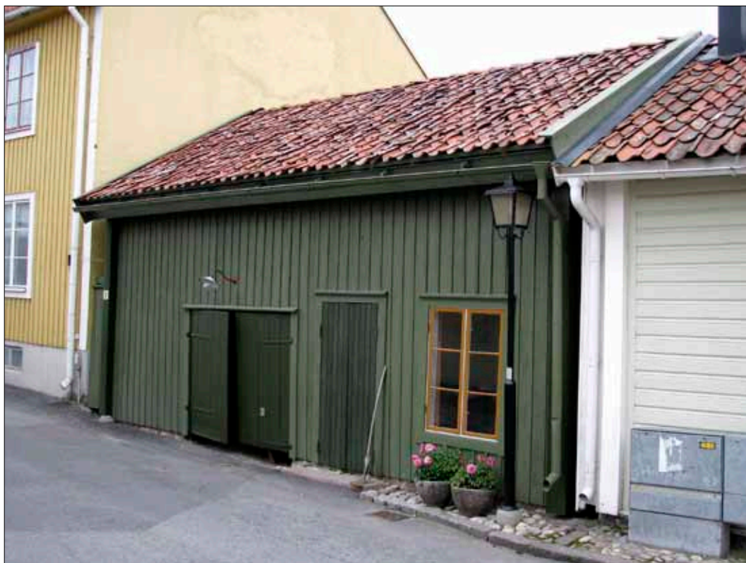
18 Fasaden mot Långgatan från sydväst efter avslutad renovering, 20080915 (D08-662).
