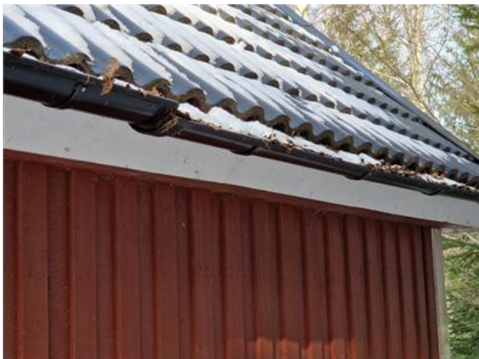
Hängrännor och Stuprör: Hängränna har lokalt gått isär och bör justeras.
