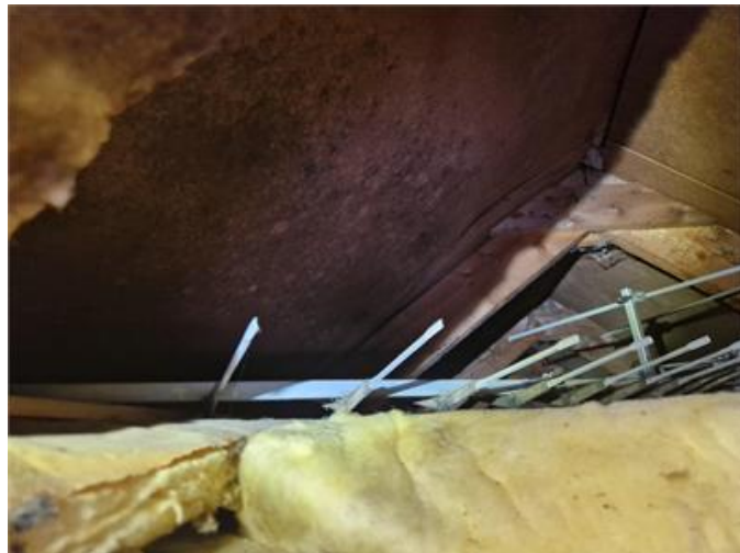
Vy på nockvind mot underlagstak
