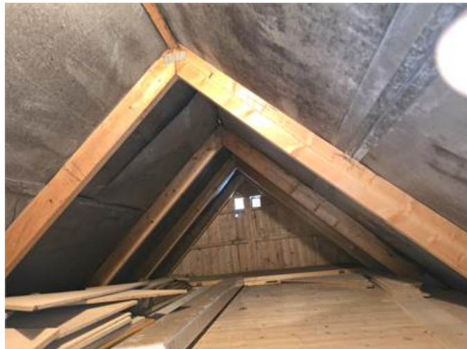
Överblick del av vinden.
