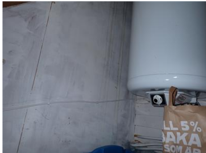
Rinnmärken samt varmvattenberedare under trapp.
