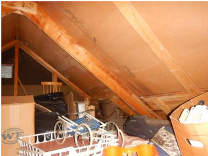
Missfärgning på takskivornockvind.
