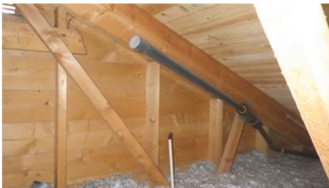
Rör från centraldammsugaren som avslutas på vinden
